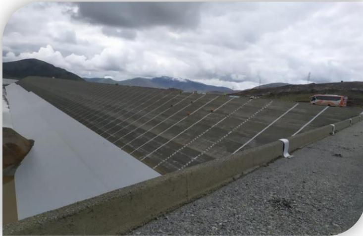
En el caso presentado se analiza un sistema de geomembrana expuesta que adopta un compuesto especial de policloruro de vinilo plastificado termoacoplado a un geotextil, anclado con un sistema de anclaje y diseñado para aceptar movimientos y asentamientos diferenciales en la presa de relaves Las Bambas.
